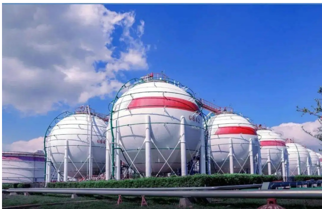
油库及化工罐区
