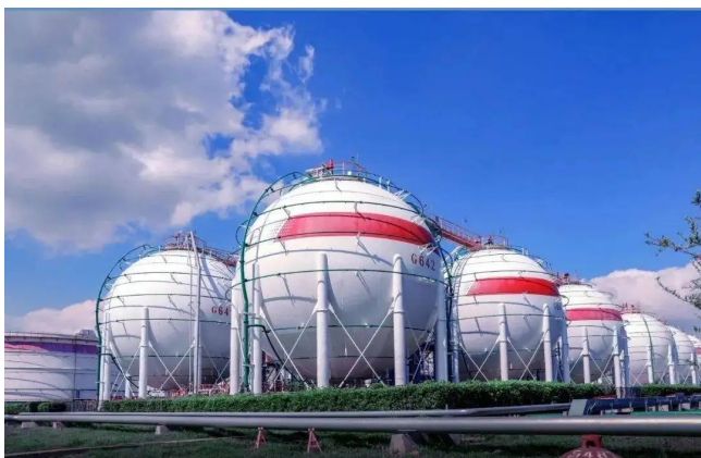
油库及化工罐区
