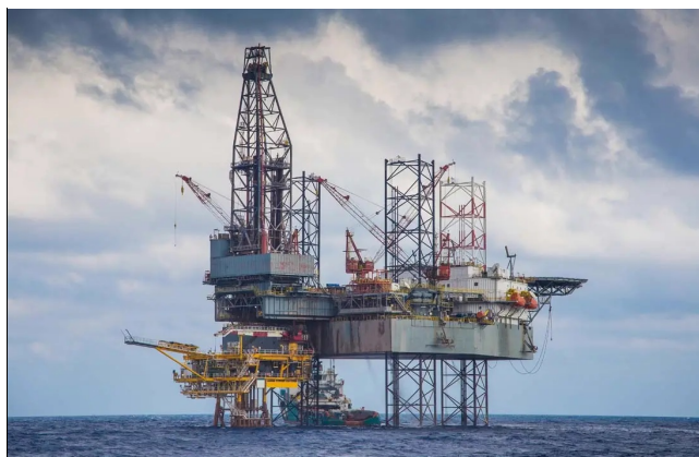
海上钻井平台及油田井架等场所
